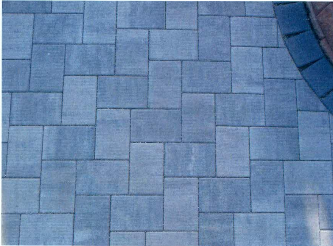
Bild: Caldera, Verlegebild Fischgrätverband
